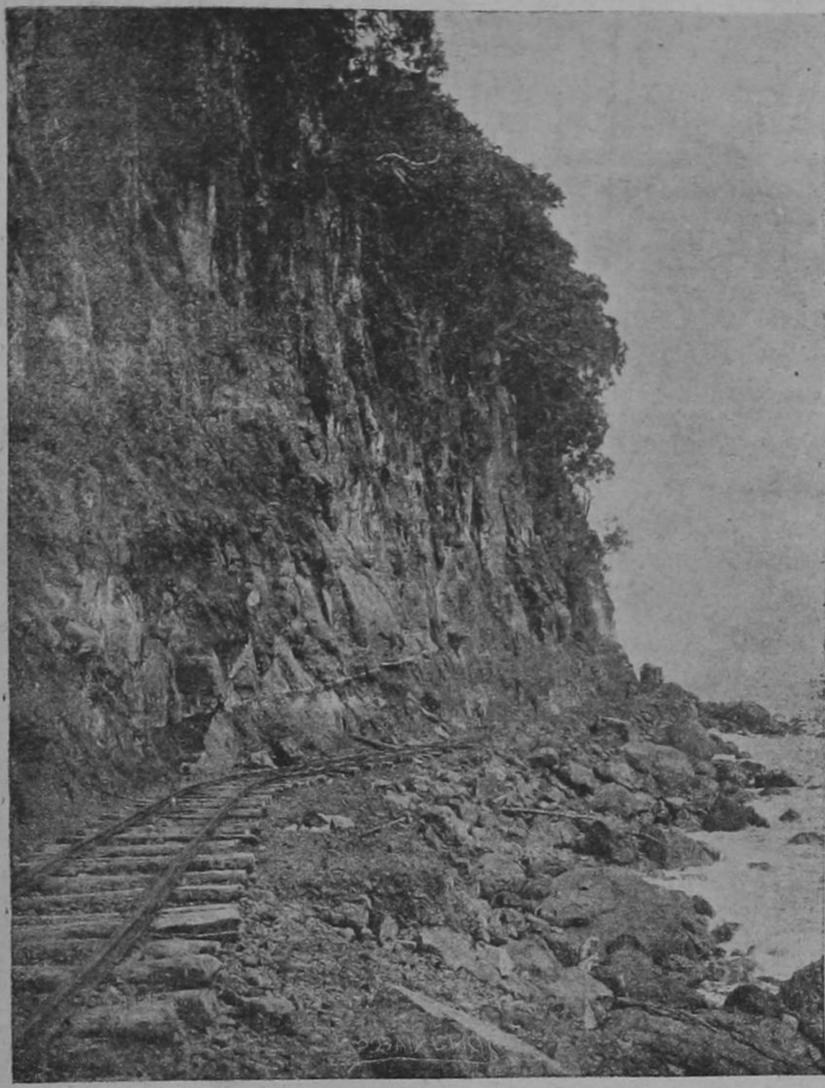
Roca de Carballo, que amenaza gran peligro, sobre todo en la estación lluviosa, por los constantes desmoronamientos. Para subsanar el mal se piensa hacer un relleno de 50 metros de ancho con un buen tamar, á fin de retirar la vía férrea del pie de la roca.
